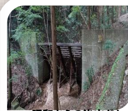
昭和からの治山ダム
